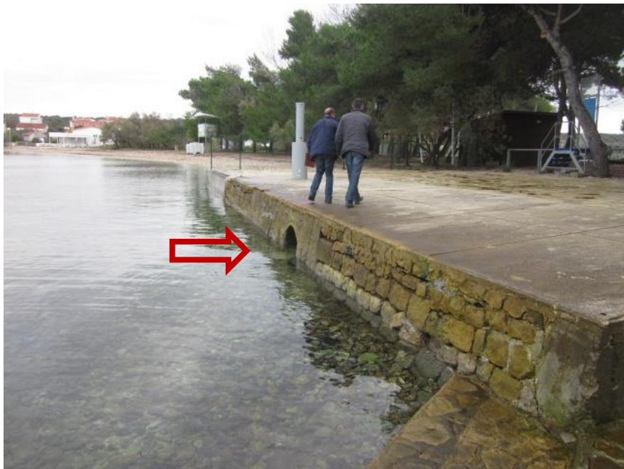
Slika: obalni ispusti oborinske odvodnje
