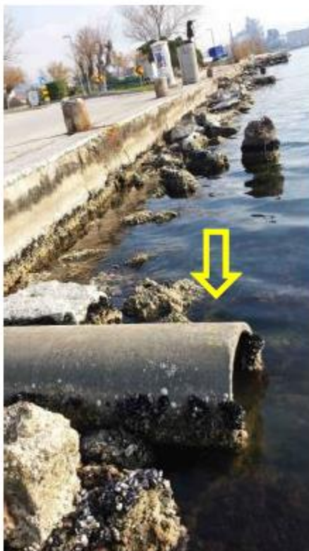
Slika: obalni ispusti oborinske odvodnje (Kaštel Sućurac)
