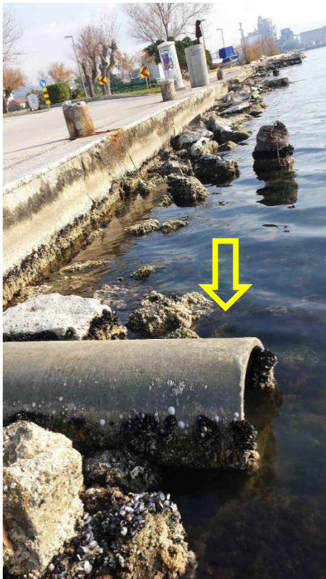
Slika: obalni ispusti oborinske odvodnje (Kaštel Sućurac)
