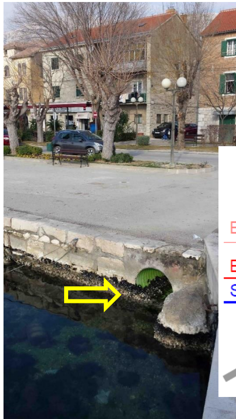
Slika: obalni ispusti oborinske odvodnje (Kaštel Sućurac)
